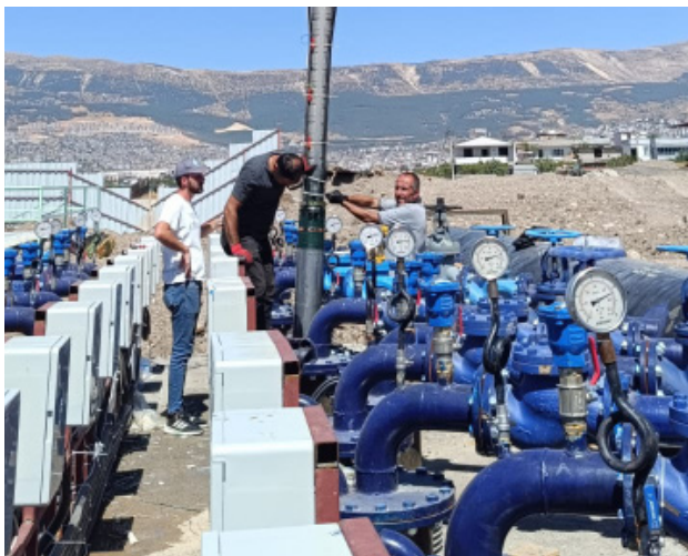
Das Wasser wird durch eine 12 km lange Rohrleitung transportiert.
