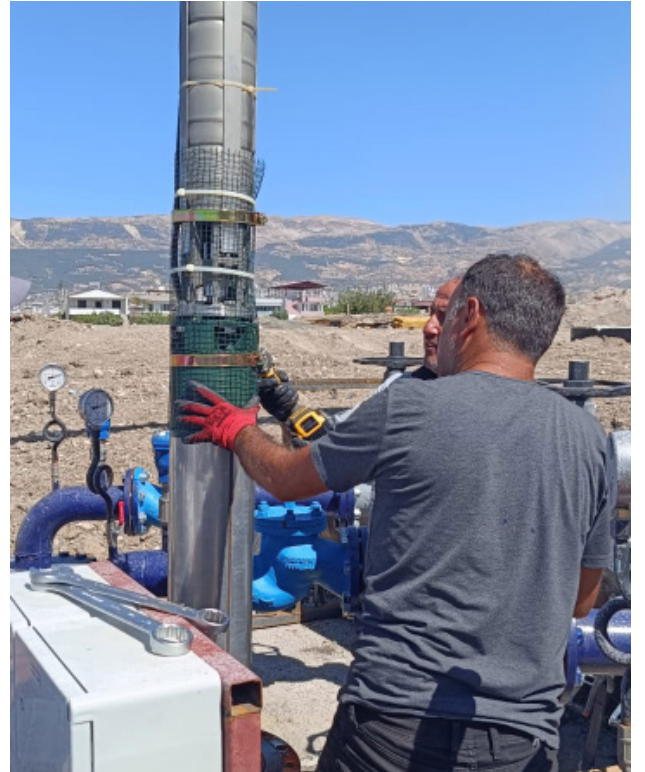
22 adet paslanmaz çelik dalgıç pompa ve motor İmpo tarafından sağlanmıştır.
