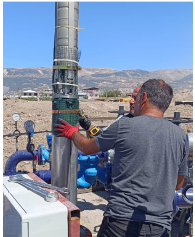
22 pompe e motori sommersibili in acciaio inossidabile İmpo garantiscono il pompaggio dell'acqua.
