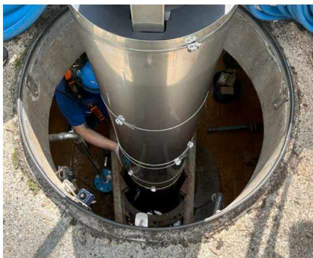
Il gruppo pompa-motore è lungo 3 metri e pesa oltre 1000 Kg.
