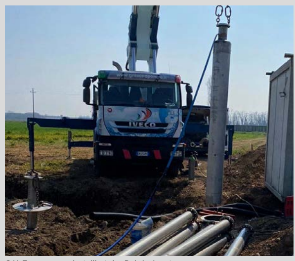
G.N. Tecnopompe installiert das Bohrlochsystem
