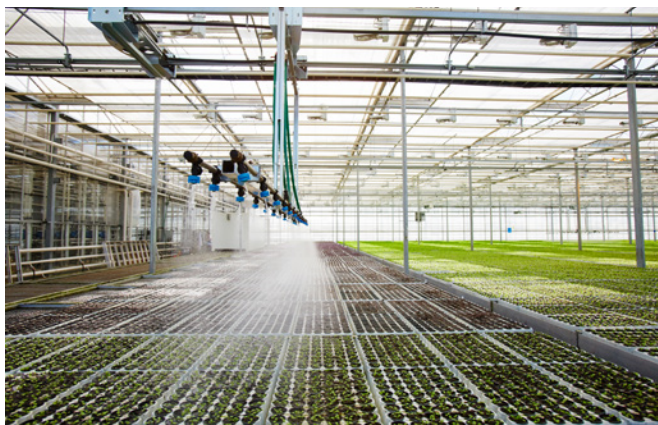
Nella fertirrigazione la miscela di acqua e fertilizzante viene distribuita nell'impianto in maniera precisa ed ad alta pressione. Per questo vengono utilizzate pompe multistadio per il rilancio e l'aumento di pressione.
