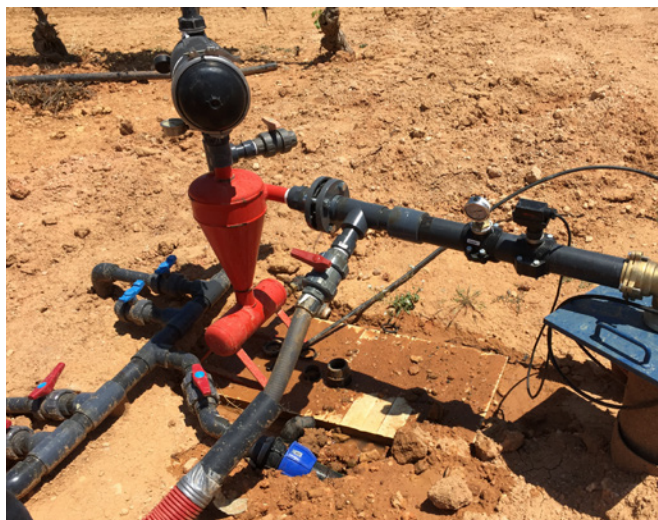
Installazione in pozzo del Sistema Alta Efficienza 4"
