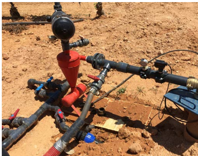
Brunnenloch, in dem das 4" High efficiency System eingesetzt ist.
