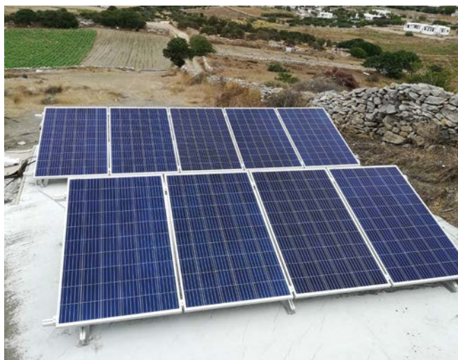
Das System wird von neun Solarpanelen (Standard Polykristallin 270 Wmp) betrieben.
