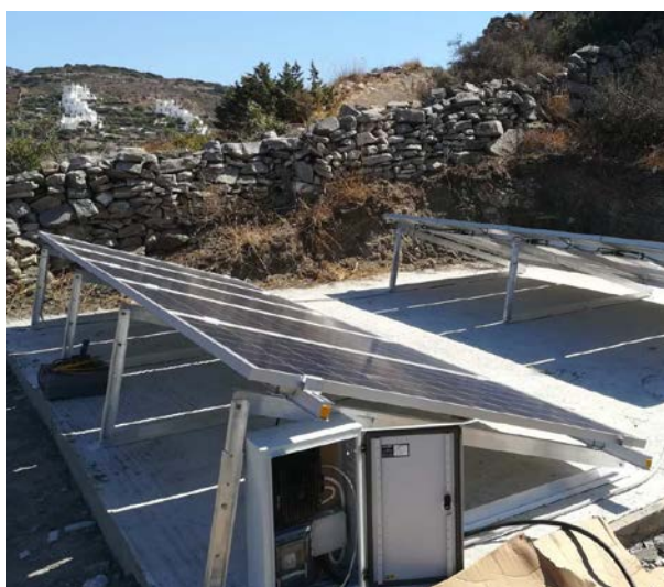
Der eingesetzte Frequenzumrichter Drive-Tech MINI Solar 2.015 MP ist werkseitig mit Bluetooth 4.0-Konnektivität ausgestattet und kann über die Mobile App aus der Ferne gesteuert werden.
