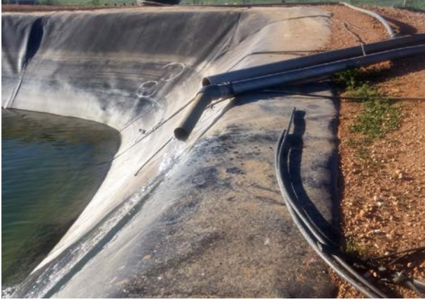
Mithilfe der Sonneneinstrahlung wird das Wasser aus dem Brunnen gepumpt.
