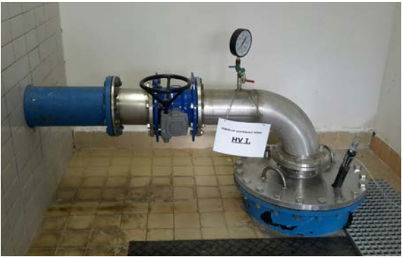
Die Brunnenanlage wurde von PUMPA a.s. analysiert und schließlich in Zusammenarbeit mit Franklin Electric erneuert.
